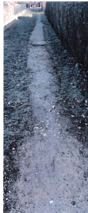
Hervorstehende Schachtabdeckung
