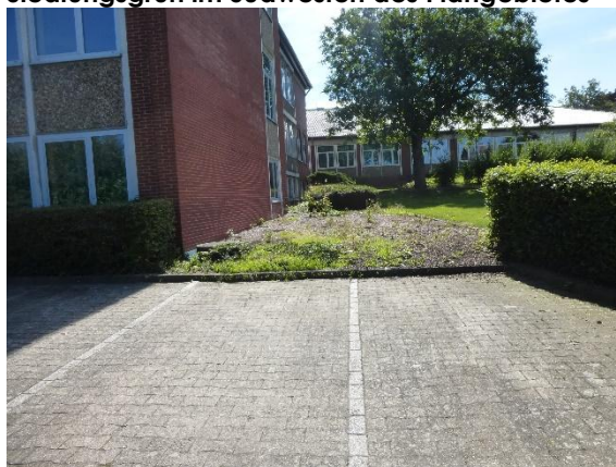
Foto 4: Parkplatz und Blick von Westen auf Schulgebäude
