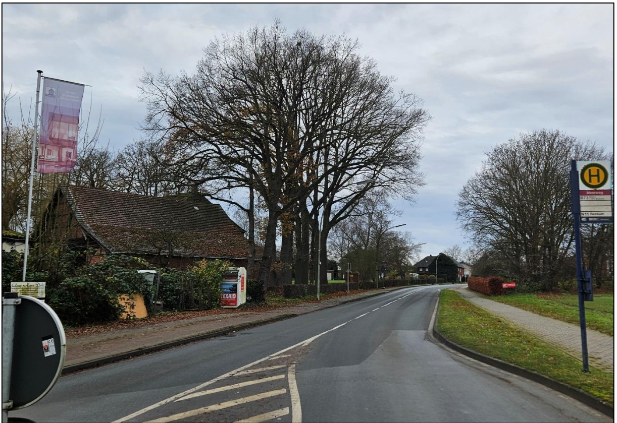
Abbildung 11: Blick auf die Straße „Mauritz“ südwestlich des Plangebietes, links altes Hofgebäude, rechts Plangebiets-Grenze (Blickrichtung Westen).
