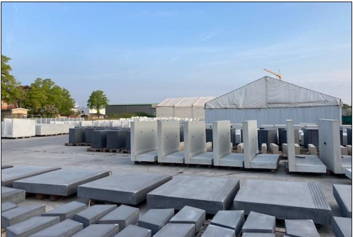
Abbildung 3: Lagerung von Betonfertigteilen innerhalb des Änderungsbereichs (Blickrichtung Nord-osten).
