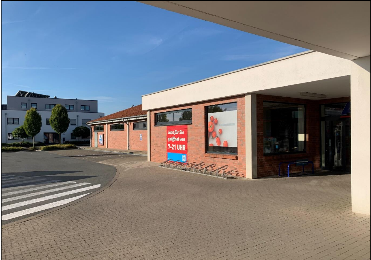
Abbildung 4: Blick auf den Erweiterungsbereich im Osten des Gebäudekomplexes zur Stellplatzanlage (Quelle:DHP)
