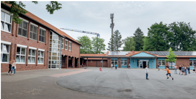
Die OGS wird erweitert. Der Rat stimmte Anfang April für die Umsetzung des knapp 4 Millionen teuren Umbaus.
