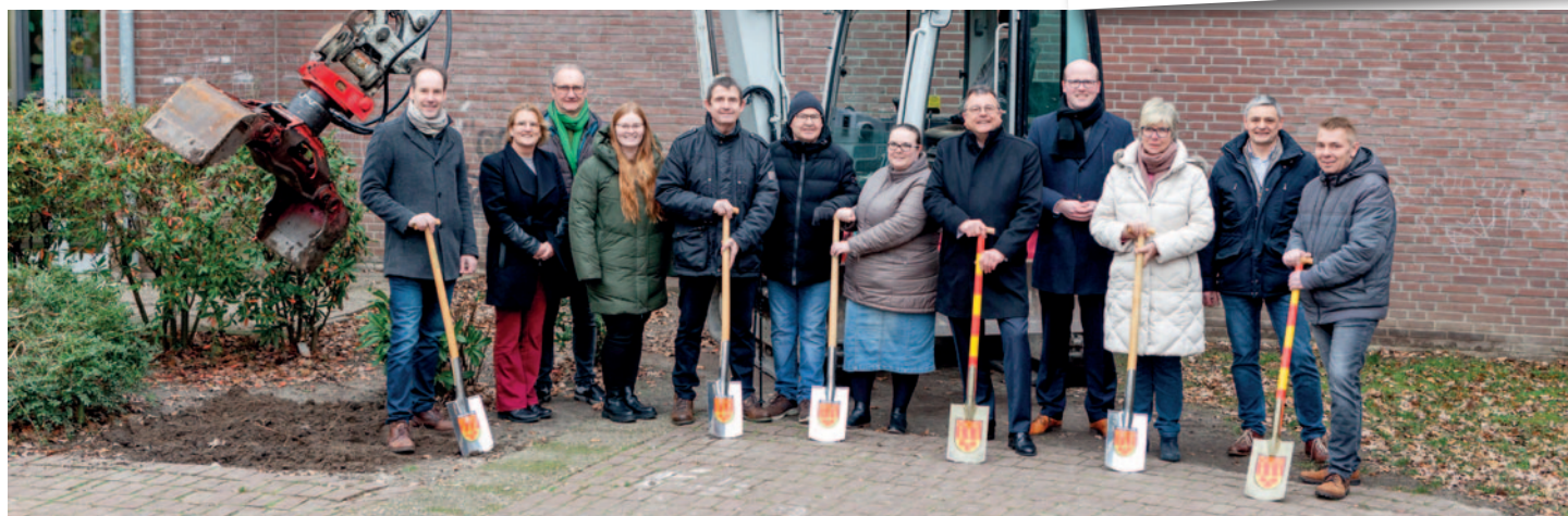
Der 1. Spatenstich für die Erweiterung des Schulstandorts Liesborn des Grundschulverbunds Wadersloh erfolgte im Dezember 2023.
