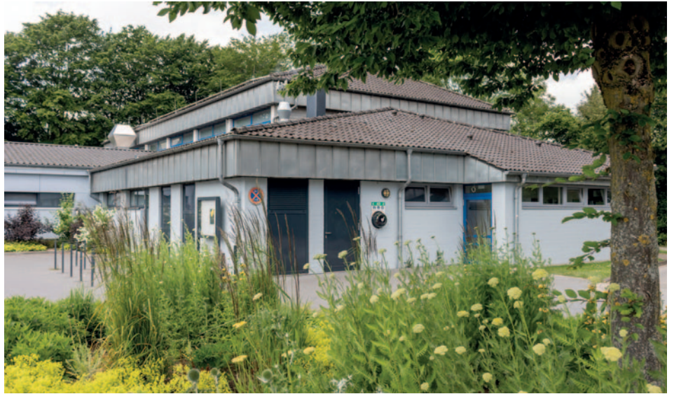
Nachdem das Lehrschwimmbecken bereits umfassend saniert wurde, erfolgt nun ein 3. Bauabschnitt, der die Sanierung der Sporthalle vorsieht.
