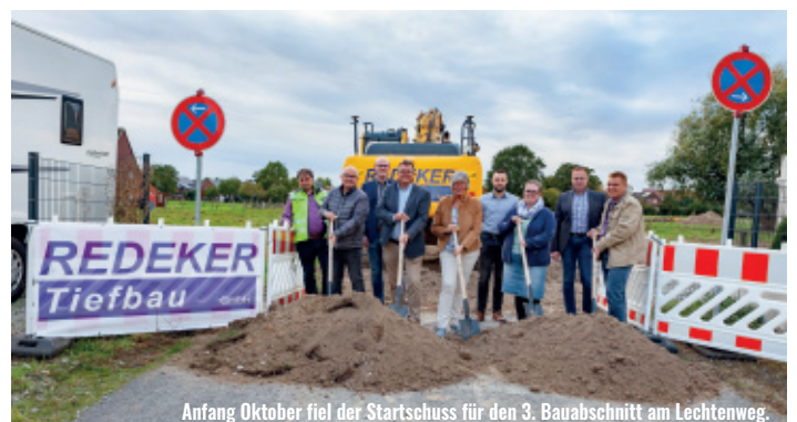
Ende Juni erfolgte der symbolische Spatenstich für „Diestedde West III“.
