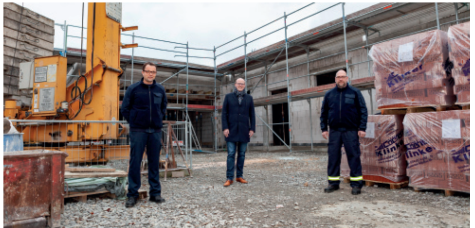
Hendrik Künneke (Zugführer, Feuerwehr Liesborn), Boris Kruntünger (Baudezernent, Gemeinde Wadersloh) und Michael Linnemann (Wehrführer, Freiwillige Feuerwehr Wadersloh) besichtigen Ende November die Baustelle in Liesborn.
