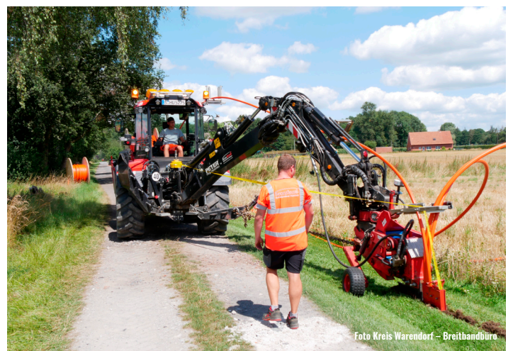
Kabelflug Foto Kreis Warendorf – Breitbandbüro
